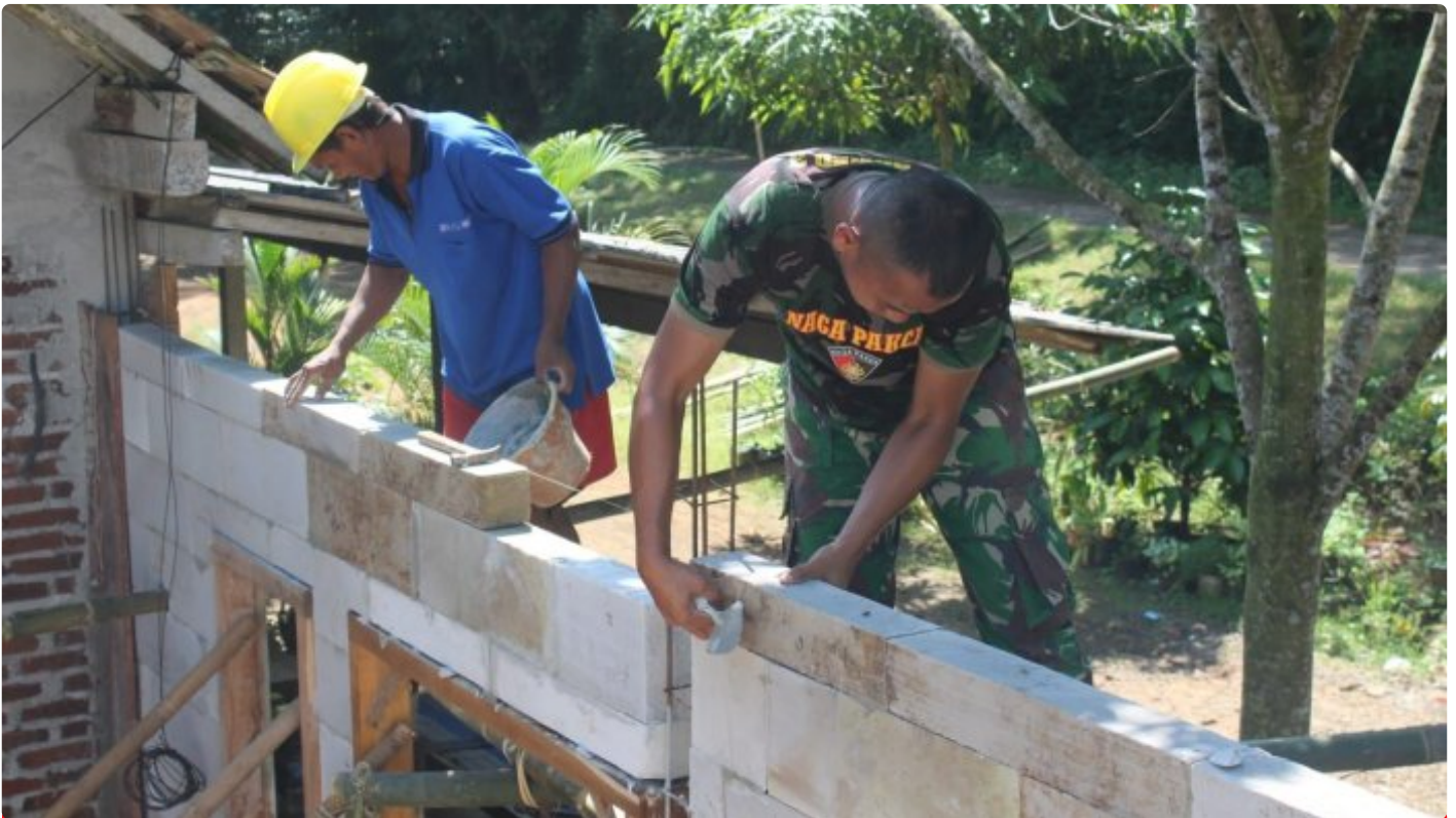
Pemasangan bata di rumah Bp Riyanto pembangunan RTHL
